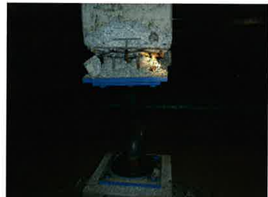
写真 2.2.10 鉛ダンパーの取付け部の損傷
