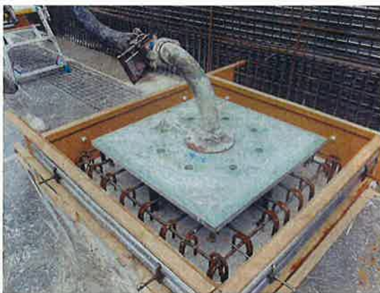
写真7. 加圧法によるベースプレート下部コンクリート充填
