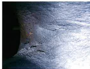
写真 2.2.6 振幅毎の亀裂一例(振幅5mm、9000回時)
