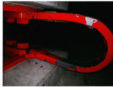
写真 2.1.2 ボルトの回転および塗装剥離
