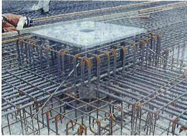
写真5. 複雑に配筋が入り組んだ免震基礎部
