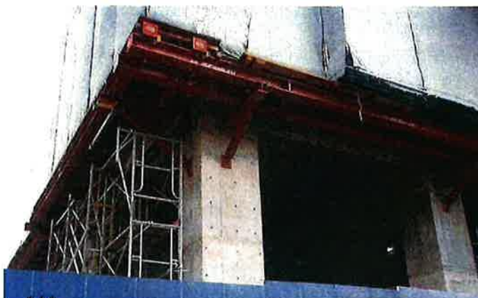
写真4. 免震層上部のブラケットで支持される外部足場
