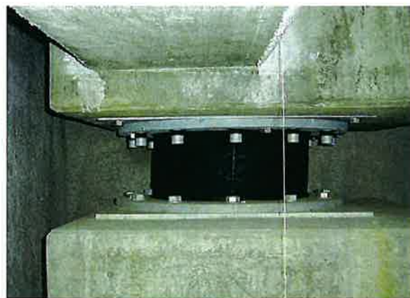
写真8. 免震層上部躯体の乾燥収縮による変形の事例
