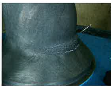
写真 2.2.5 振幅毎の亀裂一例(振幅100mm、200mm各3回後)
