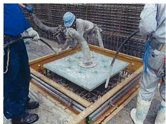
写真7. 加圧法によるベースプレート下部コンクリート充填
