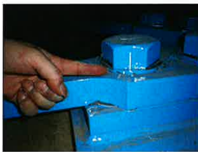
写真 2.1.2 ボルトの回転および塗装剥離
