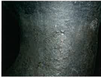
写真 2.2.1 関東の建物で確認(深さ:約3mm)
