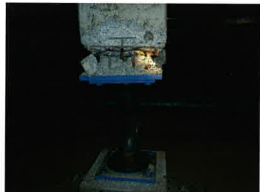
写真 2.2.10 鉛ダンパーの取付け部の損傷
