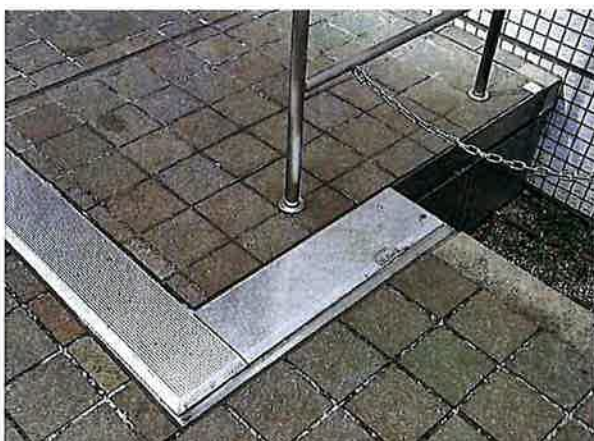
写真 2. 残留変形ではらんだ EXP. J 部
