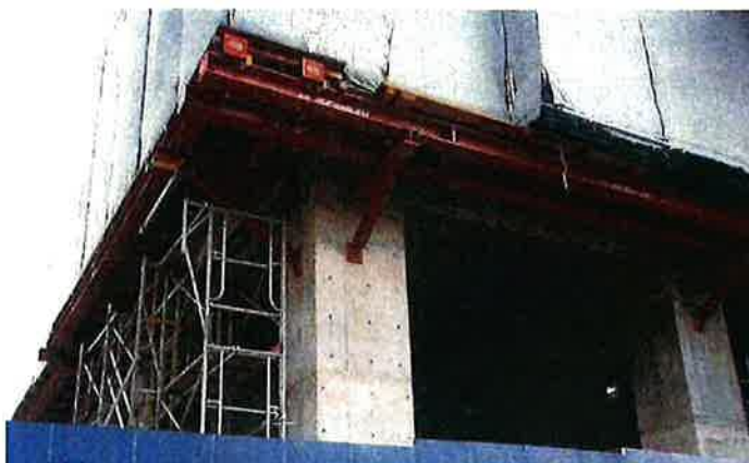
写真 4. 免震層上部のブラケットで支持される外部足場
