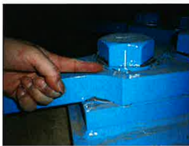
写真 2.1.2 ボルトの回転および塗装剥離
