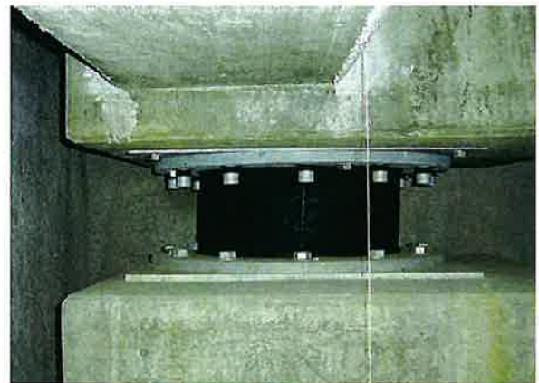
写真8. 免震層上部躯体の乾燥収縮による変形の事例
