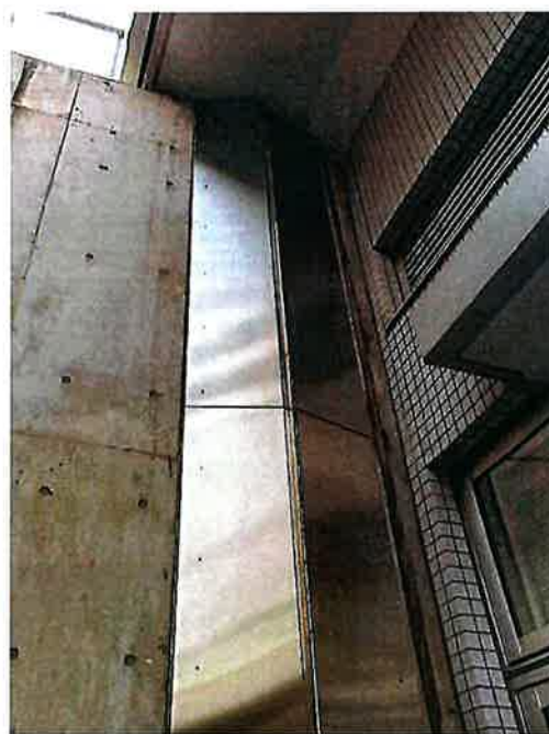
写真 2. 残留変形ではらんだ EXP. J 部
