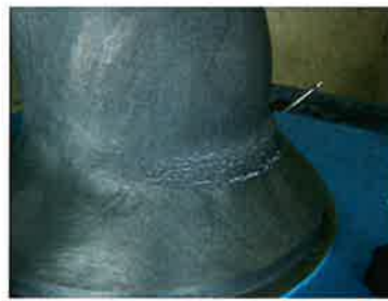
写真 2.2.5 振幅毎の亀裂一例(振幅100mm、200mm各3回後)
